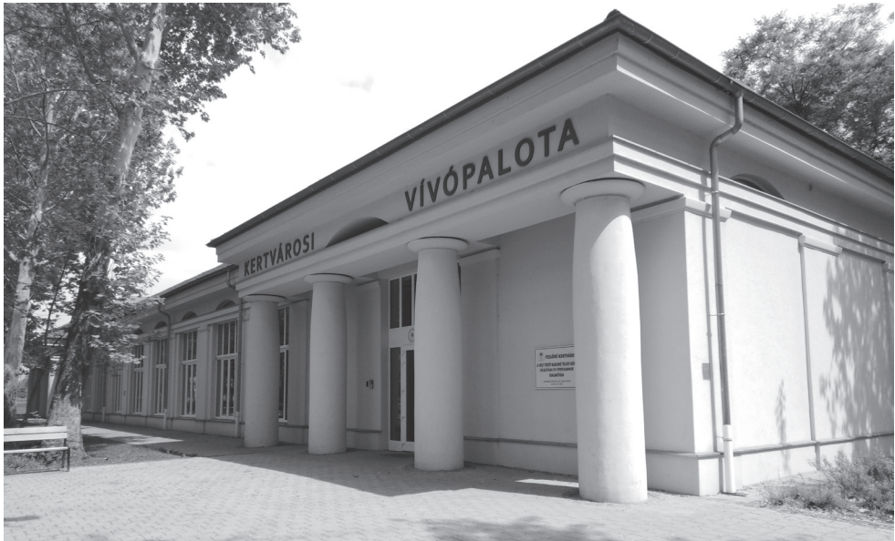
6. kép A II. Rákóczi Ferenc Katonai Középiskola egykori ebédlőépülete
