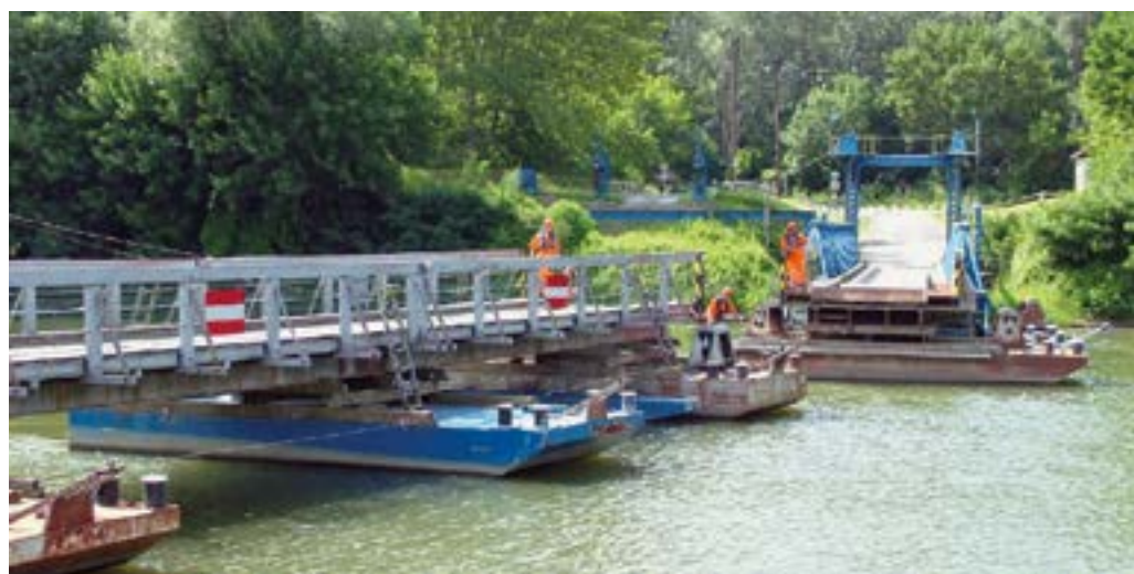
4. ÁBRA. A tiszadobi pontonhíd 49 méteres hajózányilása nyitás közben (A szerző felvétele)
