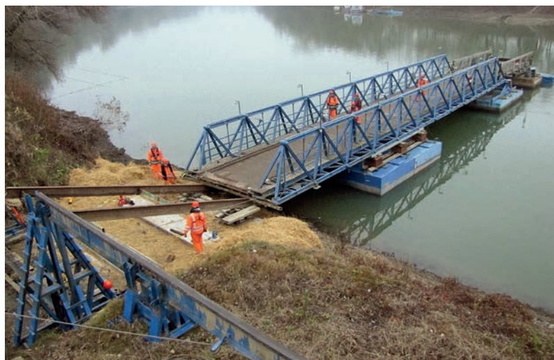
6. ÁBRA. A jobb parti Herbert-nyílás pontonokra csúsztatása a segédgerendákkal [7]
