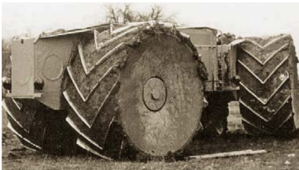
3. ÁBRA. A Lauster-Wargel LW 5 jármű két összekapcsolt járóképes tagja. A kerékdobokon jól kivehetők a vonóerő átadását biztosító hatalmas, halszálkamintás kapaszkodólapok [2]
