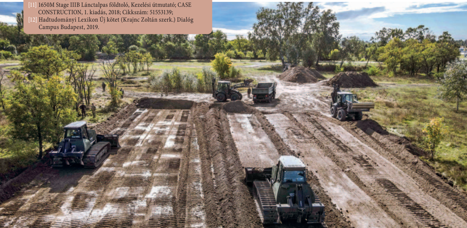
9. ÁBRA. Lánctalpas buldózerek és közepes teljesítményű univerzális gépek géplánca gyakorlatban [9]
