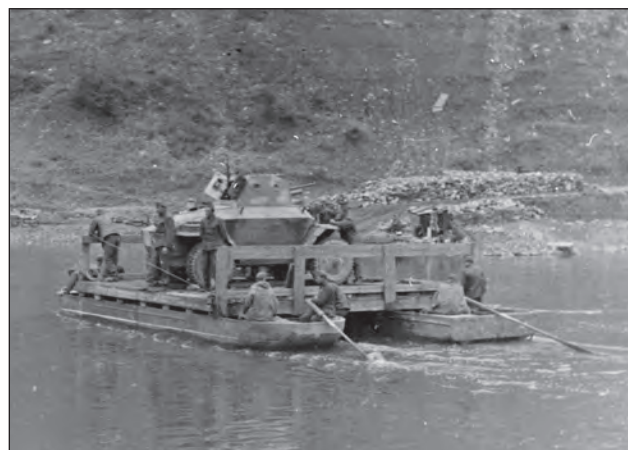
8. ábra. Az 1. lovasdandár páncélgépkocsi századának Csaba páncélgépkocsijának áthajózása a Dnyeszteren (Forrás: HTM-50892)
