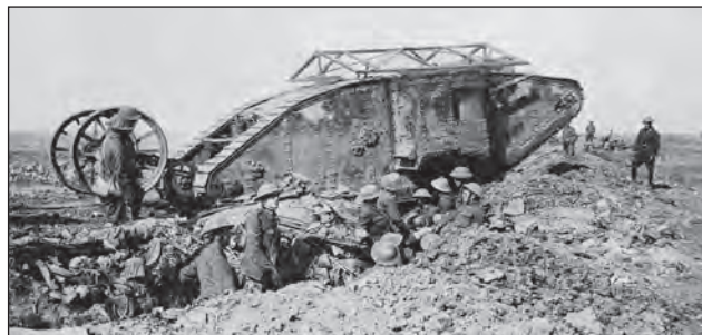
2. ábra. Egy angol gyártmányú Mk I (Male) harckocsi. Az eszközök első bevetésére 1916. szeptember 15-én, a somme-i fronton, Martinpuich és Combles települések között került sor [10]
