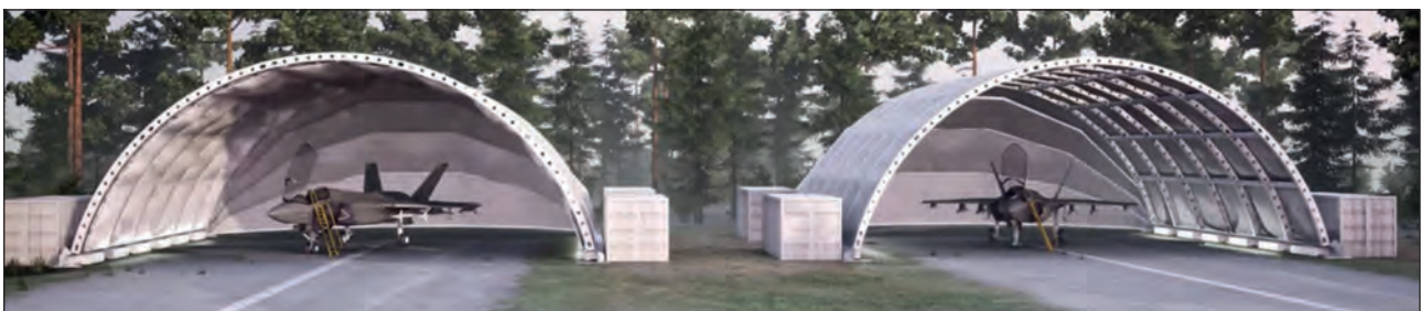
27. ábra. Radarfelderítés elleni belső bélés alkalmazása [31]
