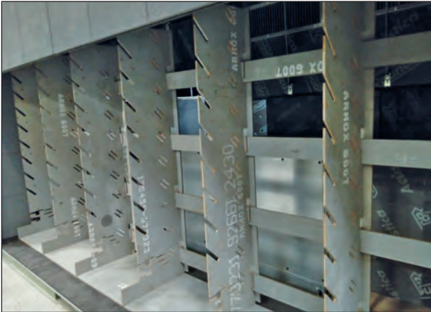
9. ábra. A lövedékcspada beépítés közben (Fotó: Bimbó István)
