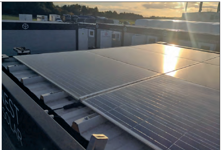
23. ábra. A Continest konténerek napelempaneljai masszívak, ellenállnak a fizikai behatásoknak, különös tekintettel az összecsuksás, kinyitás folyamataira és szállításkor egymásra halmozásra (Forrás: Continest Technologies Zrt.)
