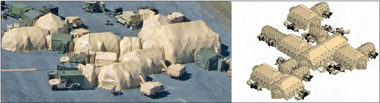
17. ábra. Az amerikai TMSS sátorrendszer több különböző típusú és méretű egysége aránylag gyorsan, pneumatikus tömlőkkel felfújva telepíthető [29]
