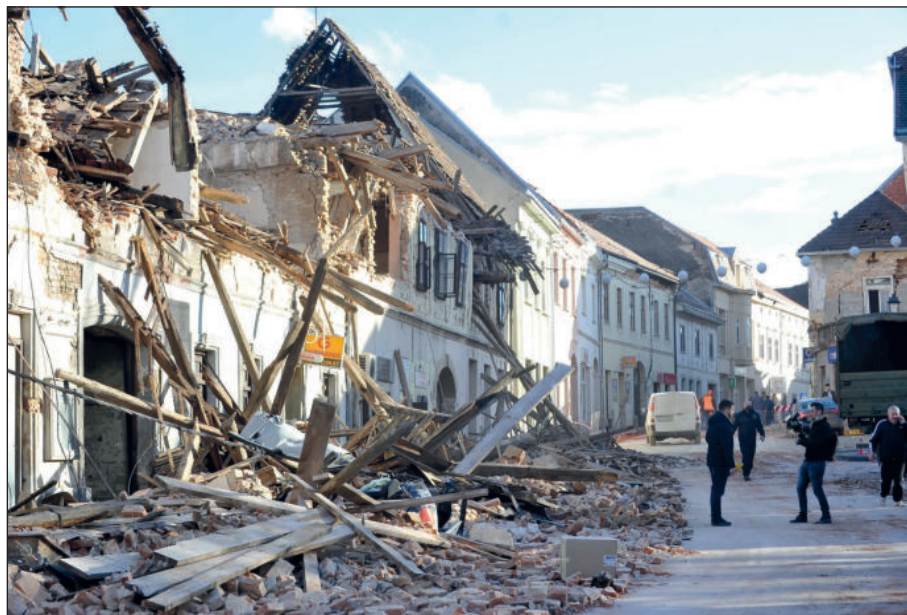
5. ábra. A petrinjai földrengés pusztítása (Forrás: [2] AP)
