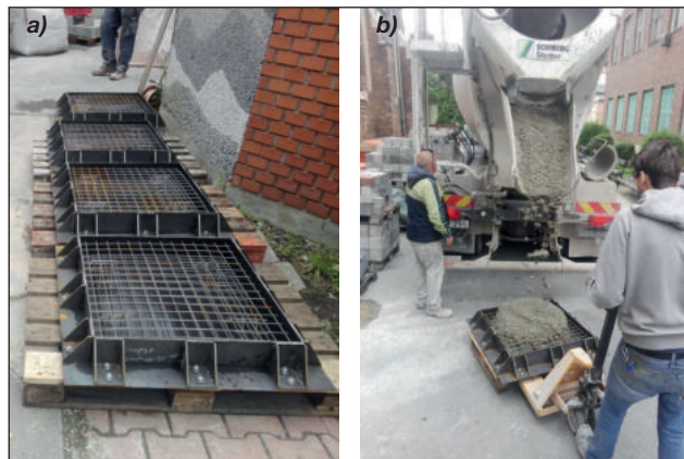
2. ábra: Betontáblák készítése, (a) előkészített acélsablonok; (b) sablonok feltöltése
