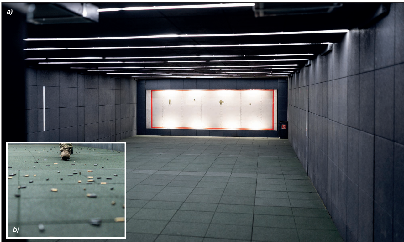
3. ábra. A lőtér teljesen zárt, a fő lőirányban energiaelnyelő és lövedékcsapda rendszer található a). A páncélozott, gurulatmentes kialakítású (gumilap lemezekkel borított) aljzat b) (Fotók: Bimbó István)
