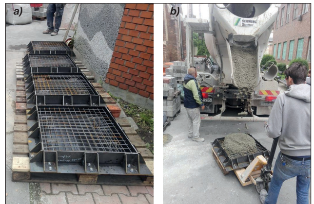
2. ábra: Betontáblák készítése, (a) előkészített acélsablonok; (b) sablonok feltöltése
