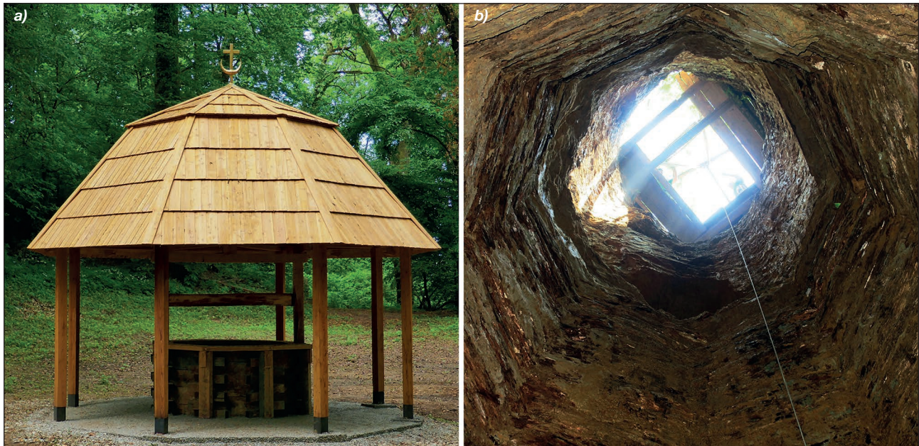
6. ábra. A várkút rekonstrukció után a) és belső szerkezete a feltárás során b)
