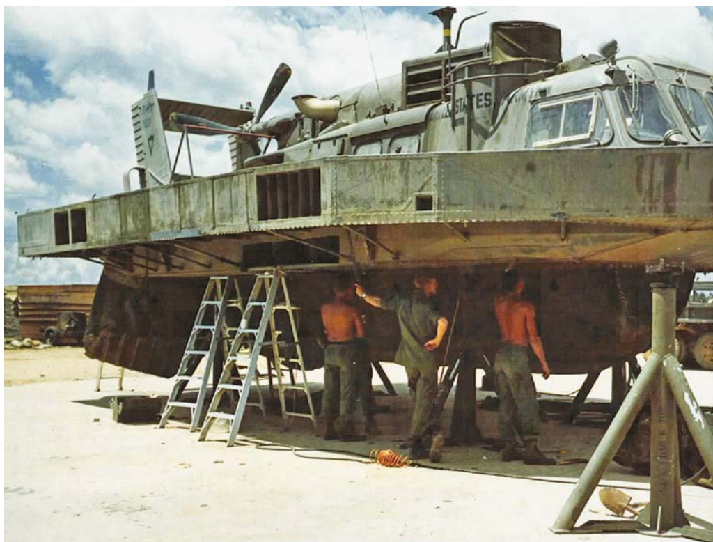
5. ÁBRA. Javításhoz előkészített ACV Dong Tamban, 1968 júliusában. A sérülést egy magas töltésnek ütközés okozta, amely leszakította a gumiszoknya egy hatméteres szakaszát. Hátul-oldalt jól láthatók a légkivezető nyílások, amelyek segítségével a kis sebességű fordulást lehetett elősegíteni (Forrás: Wikipedia)
