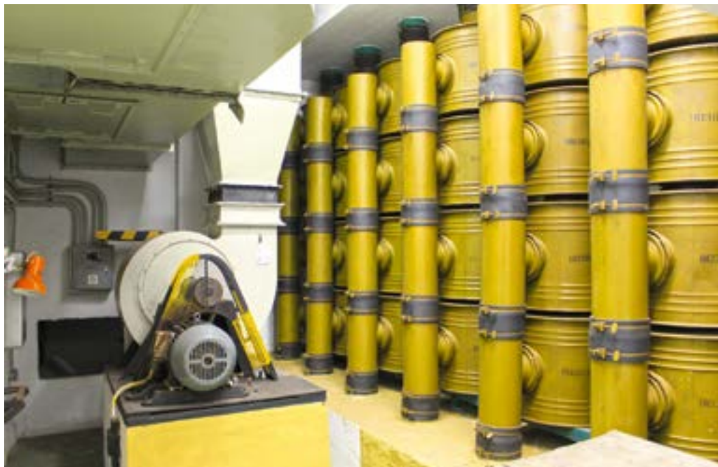
2. ÁBRA. Csoportba szerelt FP-300 típusú aktív-szén-betétes elnyelőszűrők – és mellettük a szívóventilátor – az egyik budapesti védett objektumban. Telítődésük után a kb. 58–62 kg tömegű szűrők tisztítására nem volt lehetőség, cserélni kellett őket (A szerző felvétele)
