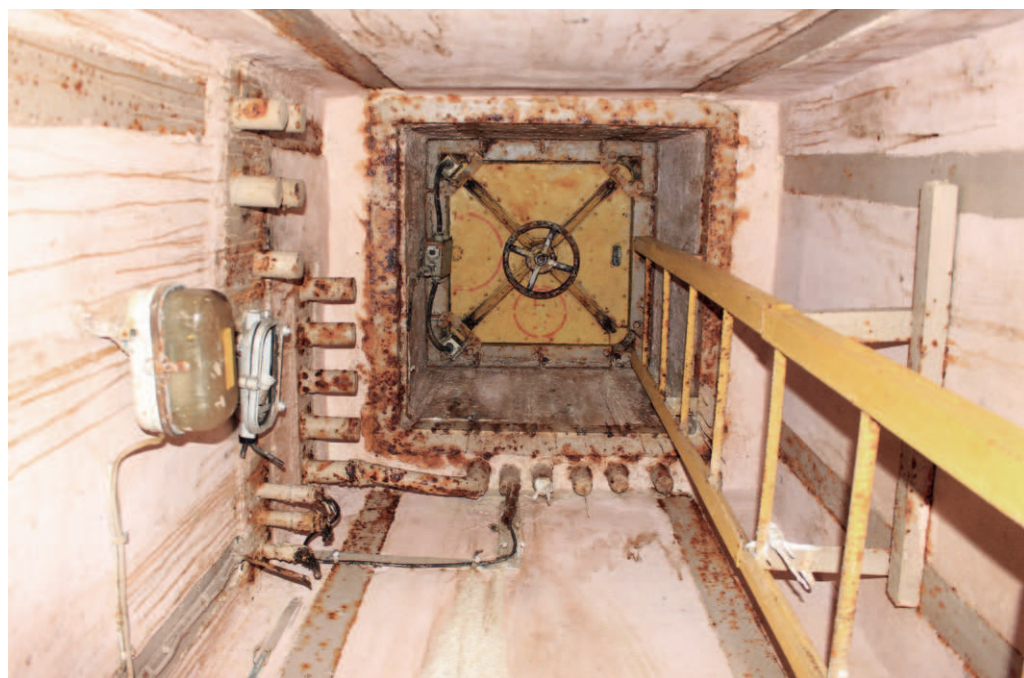
3. ÁBRA. Lengyelországban felépült BARSz 201- es jelzésű föld alatti troposzférikus híradó állomás vészkijáratának függőleges aknája, LZG 70-70 típusú páncélajtóval (A szerző felvétele)
