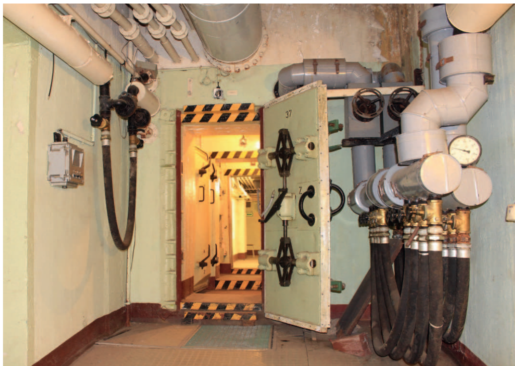
5. ÁBRA. A volt keletnémet néphadsereg Légierő és Légvédelmi Parancsnokság központi, Fürstenwalde melletti harcálláspontjának egyik bejárata DZ80-180/10 típusú szovjet gyártmányú védőajtóval (A szerző felvétele)
