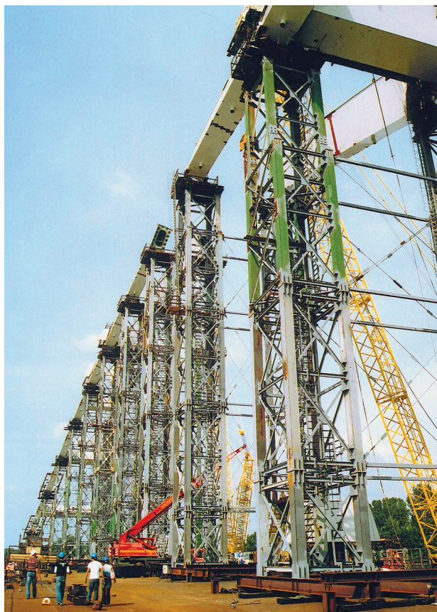
14. ÁBRA. SBG-66 gerendákból gyártott segédszerkezet [33]
