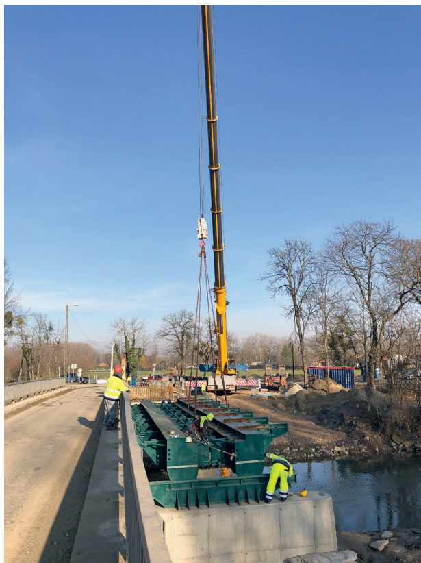
4. ÁBRA. Épül a második mosonmagyaróvári hídszerkezet 2019-ben, a régi híd mellé [3]
