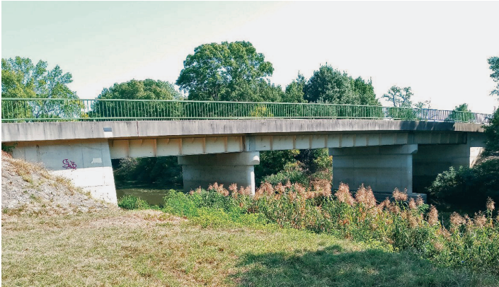
9. ÁBRA. REM-500 főtartóból épült túrkevei Hortobágy-Berettyó-híd [26]
