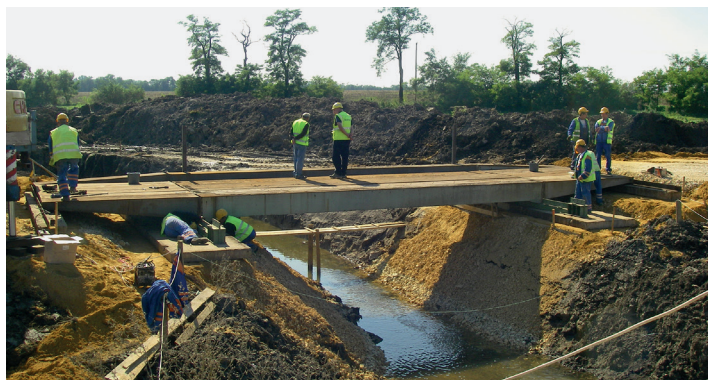
12. ÁBRA. 8,5 m-es SBG-66 provizorium 3,0 m-es rámpás elemekkel építés közben [32]
