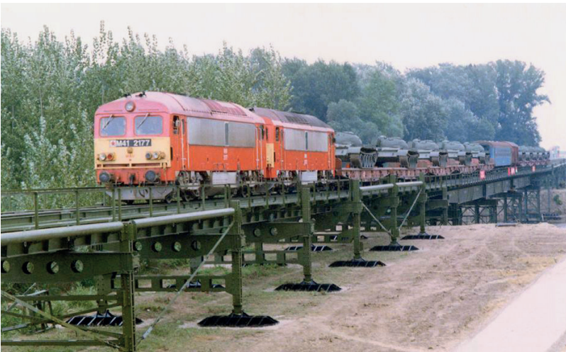
10. ÁBRA. Lakitelek és Tiszaug közötti vasúti provizórium REM-500 típusú parti nyílásokkal [23]
