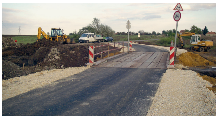
13. ÁBRA. A Csinse-patakon épített építési provizorium a közút terelőútjában [32]
