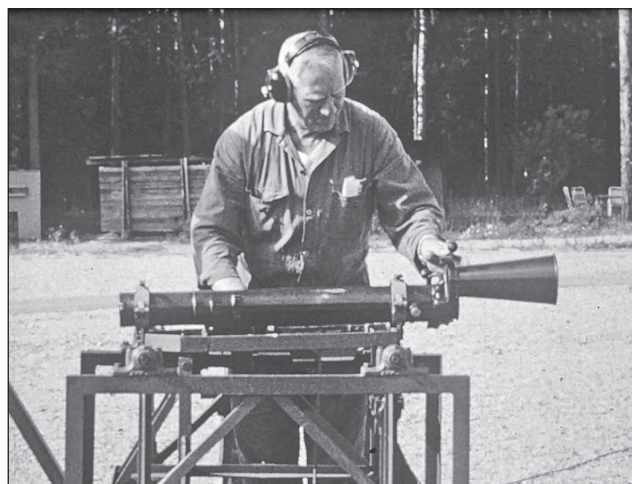
3. ábra. Lőkísérlet előkészítése az M48-as hátrasiklás nélküli fegyver egy korai változatával [7]
