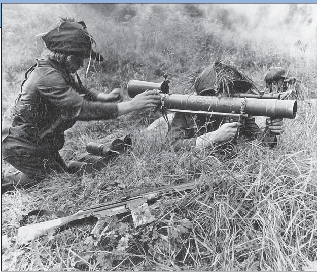
4. ábra. Az M48-as töltéséhez a Laval-fúvóka már nyitva van, mögötte a lőszer látható (Forrás: https://www.redditinc.com/ )
