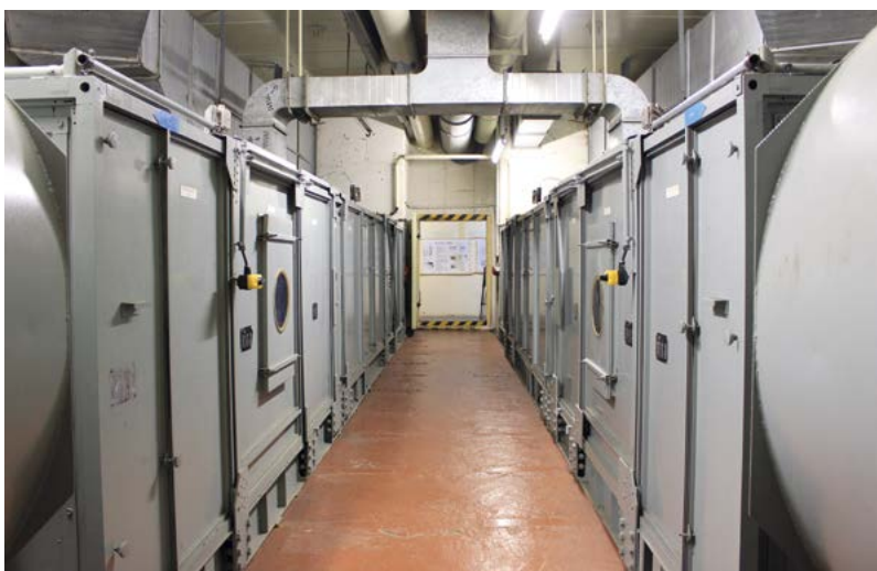
7. ÁBRA. A klímagépház a bunker alsó szintjének egyik legnagyobb alapterületű helyisége, ahol két hatalmas légkondicionáló blokk gondoskodott a belső tér hőmérséklet- és páratartalmának szabályozásáról (A szerző felvétele)
