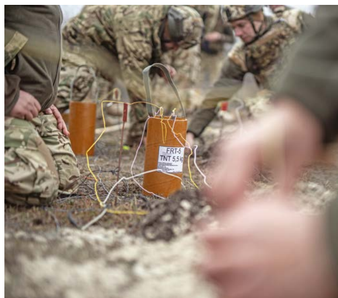
2. ÁBRA. Földrobbantó töltetek előkészítése műszaki szakfeladatok végrehajtásához (Fotók: Janó Miklós törzsőrmester / MH RF 14. mű. e.)
