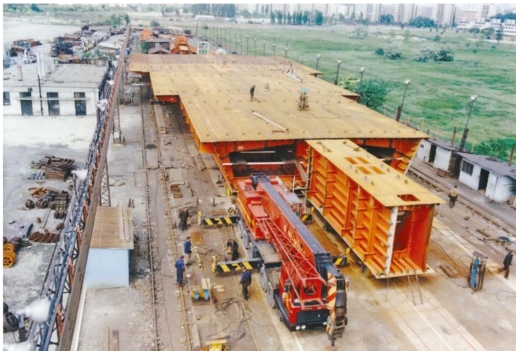
4. ÁBRA. A híd acélszerkezetének előszerelése 1979-ben Budapesten (Fotó: dr. Domanovszky Sándor)
