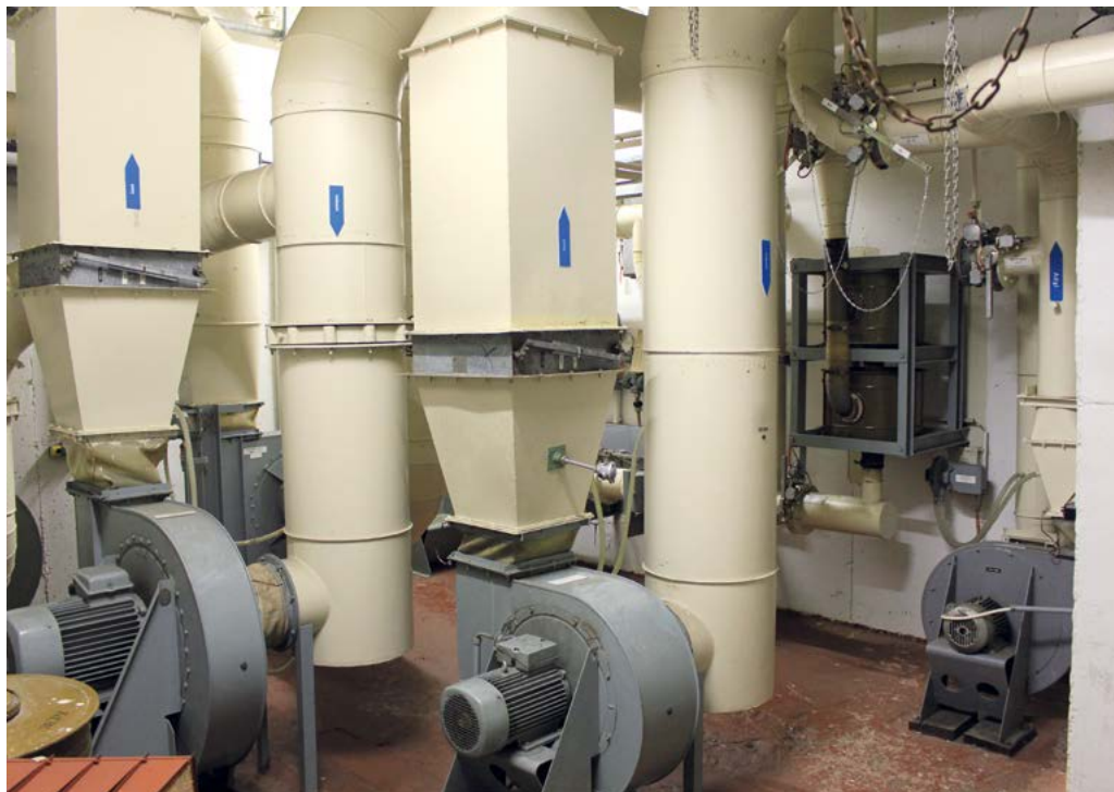
6. ÁBRA. A szellőztető gépházban működő ventilátorok feladata volt a külső, friss levegő beszívása a gázbiztos térbe, illetve a belső levegő keringtetése, az adott üzemmódnak megfelelően. A légszatórnákon két nyilakkal jelölték a levegő útját (A szerző felvétele)
