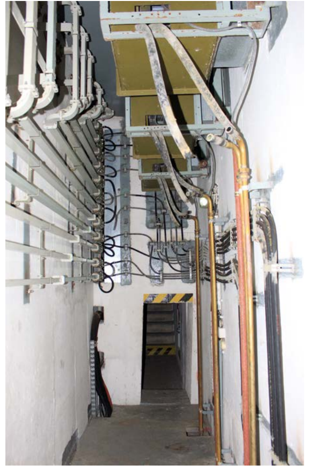
4. ÁBRA. Falra szerelt, nyomás alatt lévő csőtápvonalak vezetnek az adóktól az antennatornyok talpzataiig, majd ott egy földemáttörésen keresztül fel az antennákhoz (A szerző felvétele)
