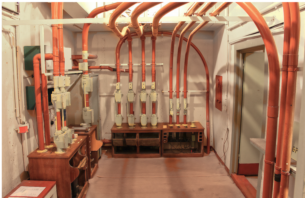
7. ÁBRA. Pneumatikus üzemeltetésű csőpostahálózat látványos részlete az egykori NDK Légierő és Légvédelmi Parancsnokság központi harcálláspontján. A Fuchsbau (Rókaluk) nevű objektumban kialakított rendszer hatékonyan segítette az építményen belüli kommunikációt, információáramlást (A szerző felvétele)
