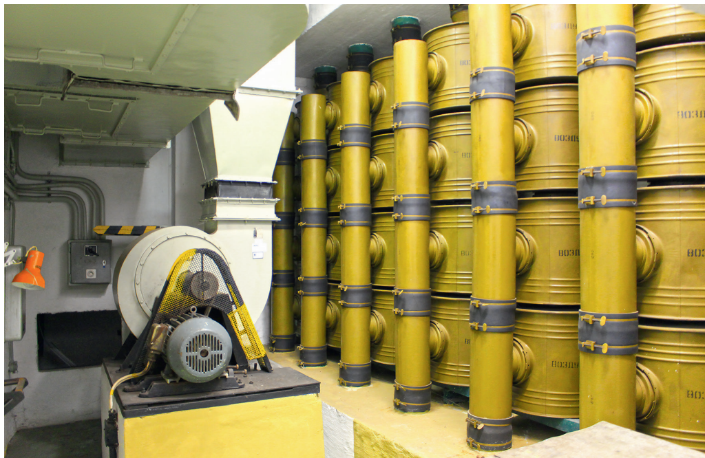
2. ÁBRA. Csoportba szerelt FP-300 típusú aktív szén-betétes elnyelőszűrők és mellettük a szivóventilátor – az egyik budapesti védett objektumban. Telítődésük után a kb. 58–62 kg tömegű szűrők tisztítására nem volt lehetőség, cserélni kellett őket (A szerző felvétele)
