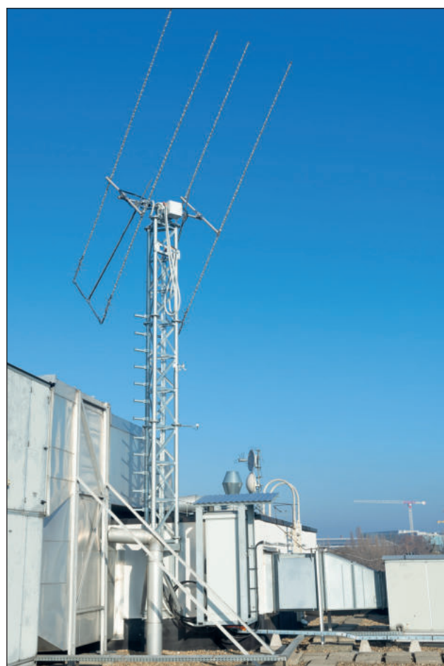
5. ábra. Az UHF frekvenciasávú földi állomás antennarendszere [21]
